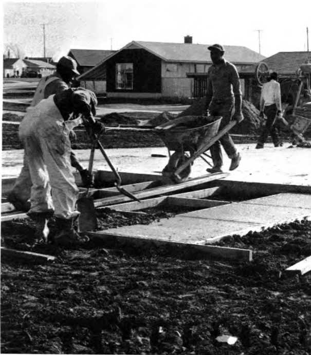
Construction laborers haul and pour concrete.
