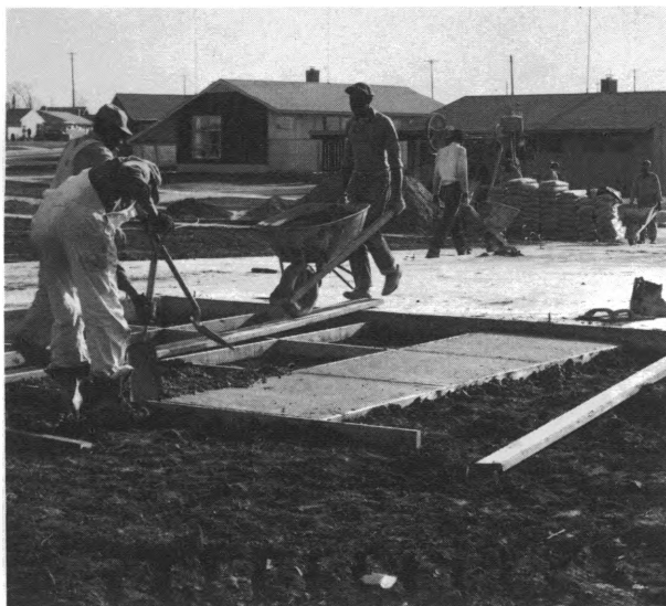
Construction laborers haul and pour concrete
